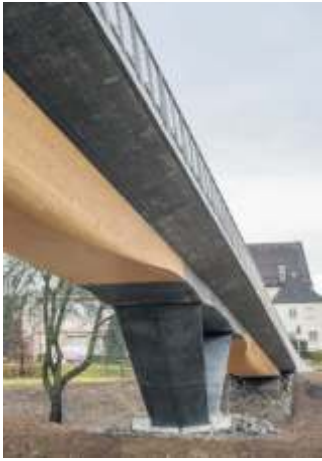
Beim Stegbau wurden Holz, Beton und Carbonfasern in neuer Weise miteinander kombiniert. Fotos: Landeshauptstadt Stuttgart/Fabrice Weichelt
